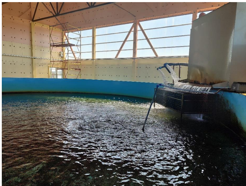
Рисунок – Дегазаторная установка с резервуаром-накопителем
